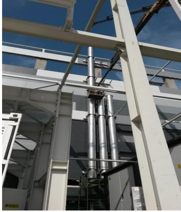
Şekil 9. Bina dışında Örnek bir baca montajı
